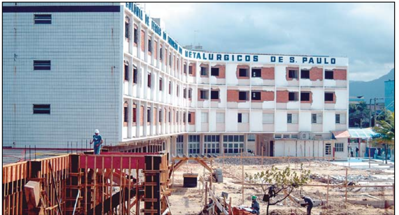
Esta parte do prédio que foi mantida é composta pelos antigos apartamentos, que estão sendo totalmente remodelados
